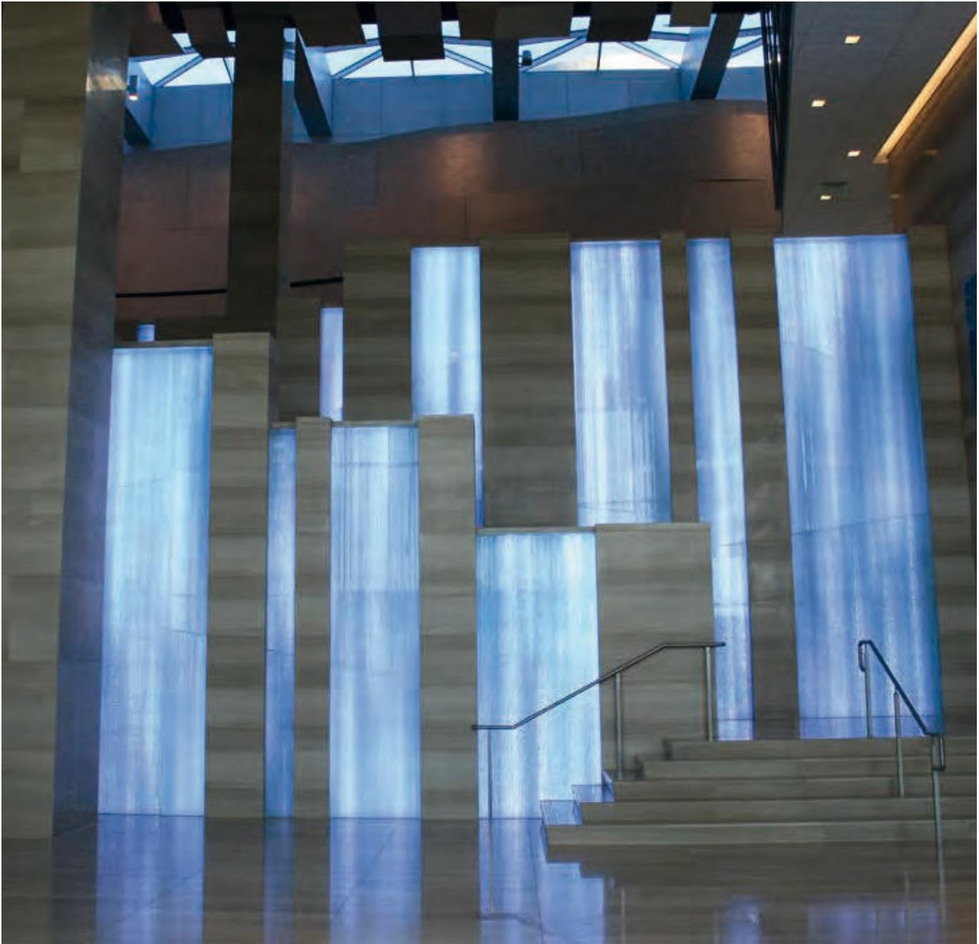
Internal Floor Tiles, Wall Cladding/Pavimento, Rivestimento Murario: Serpeggiante Polished/Serpeggiante Lucido
