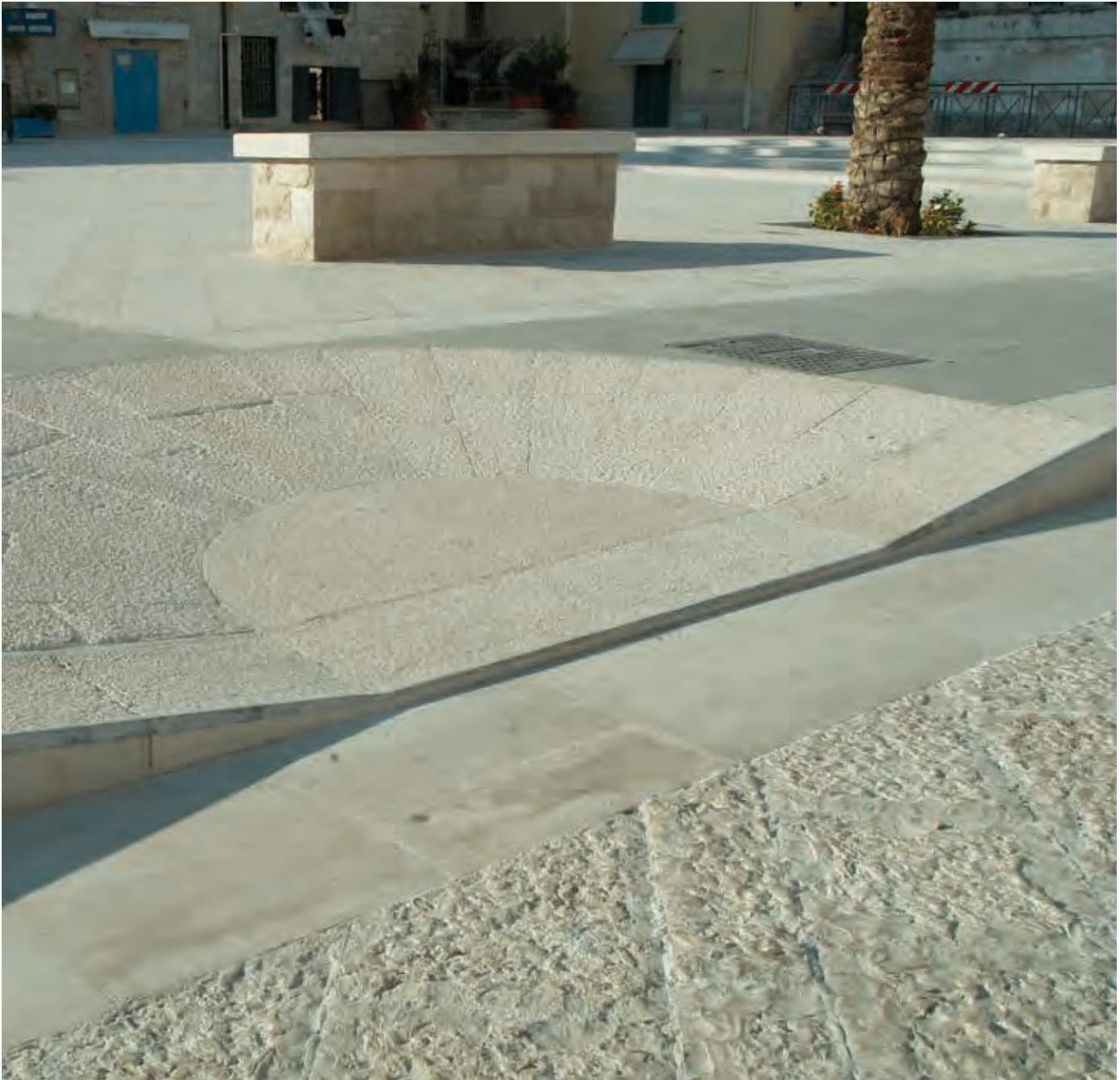
**Paving/Pavimento:** Genius Chisel/Picconata + Heavy Bushhammered/Bocciardato Grosso
